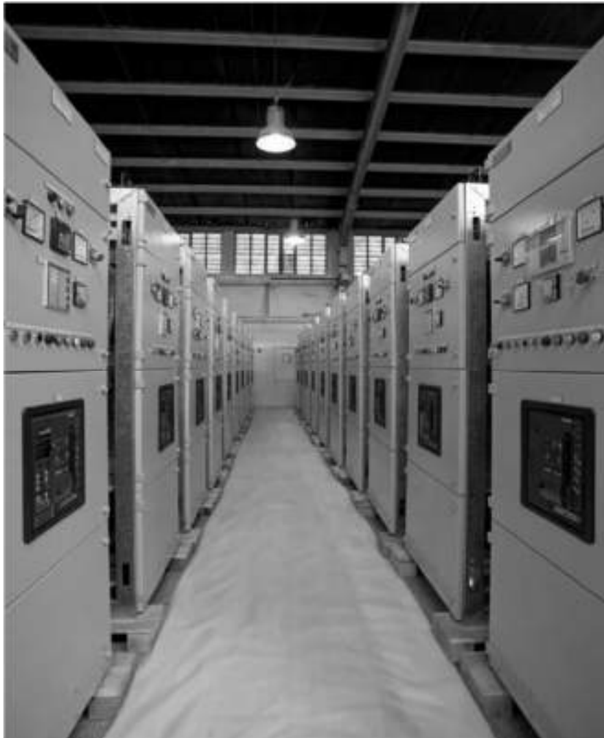
LV/ INC-OUTGOING PANEL 0.4 KV FCB TYPE
